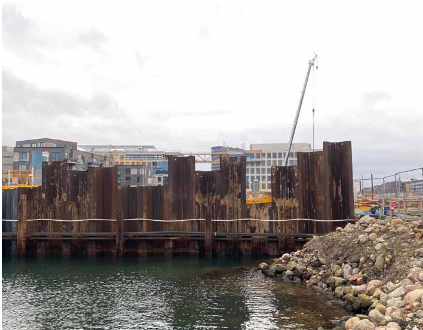
Byggeri ved Sandkaj i Nordhavn
